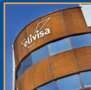
Nau al Polígon Industrial les Pedrosses Pàg. 10-11
