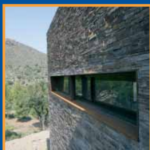
Habitatge unifaminiar a la Selva de Mar Pàg. 4-5
