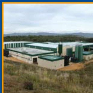
Planta de Compostatge de Solius Pàg. 6-7
